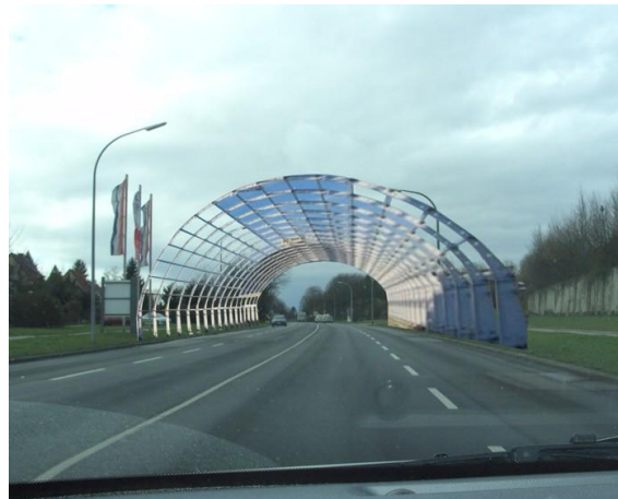
Foto: Am Krankenhaus, Blickrichtung Westen
