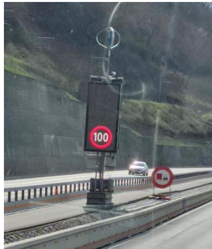
Ein kleiner Darrieus-Rotor zur Verkehrszeichen-Beleuchtung
