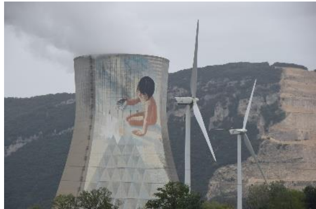
Umweltschutz-Huldigung mit Kühlturm-Bild
